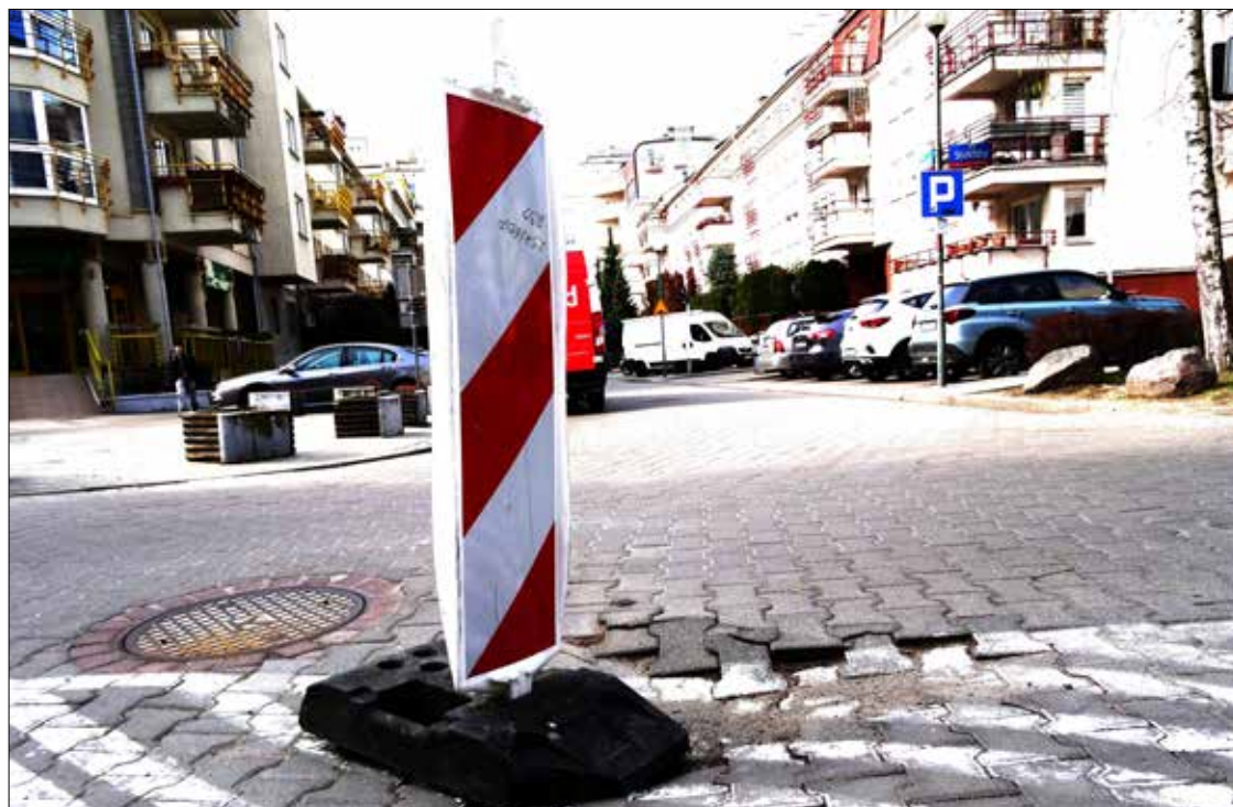
Przed MPWiK jeszcze wiele pracy by wyrównać nawierzchnię ul. Stokłosy.
